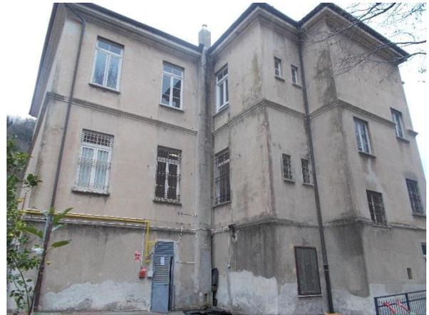
Il profilo termico della struttura è dovuto in gran parte alla sua morfologia: pareti spesse, copertura non isolata, serramenti obsoleti.
